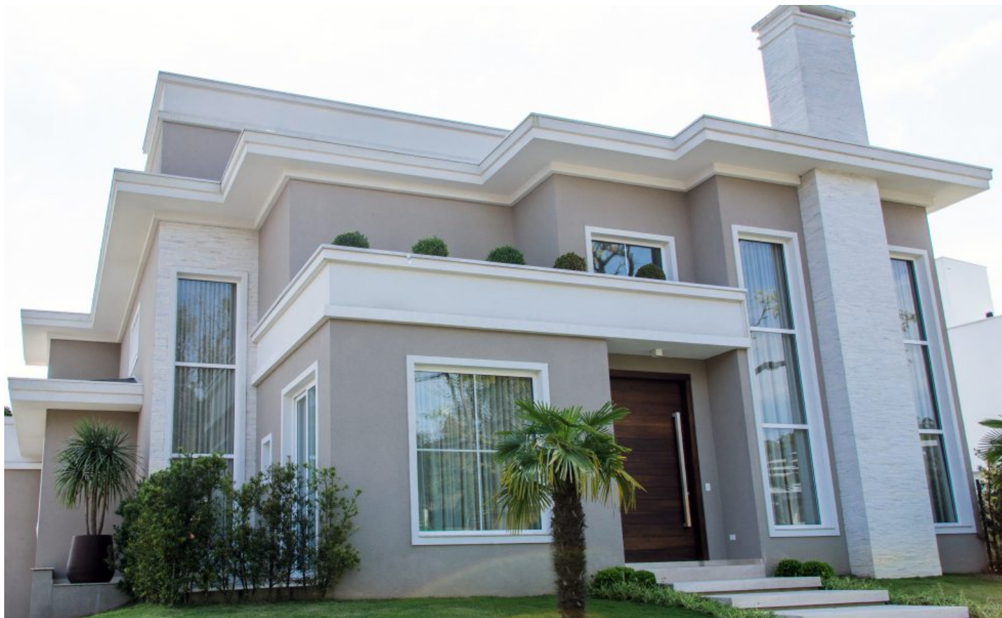
A fachada possui volumes revestidos em pedra filetada e porta pivotante de madeira
